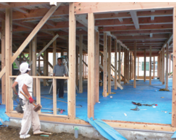
「優つくり村石神井台沼辺」は、市場流通材を使って、地場工務店が施工を行なった
