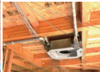
木造の梁を避けて設備を取り付ける
