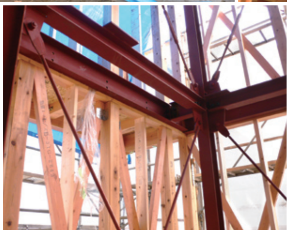
エレベーターシャフトはフレームを鉄骨で構成
